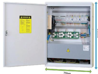
Данные приборы обеспечивают качество электроэнергии в соответствии с действующим межгосударственным стандартом ГОСТ Р Ф 13109 1997 г. в процессе автоматического регулирования величины напряжения +/-5 %. Внедрение нормализатора в офисное здание или промышленное предприятие позволит сэкономить до 32 % электроэнергии, увеличить срок службы электрооборудования в 1,5-2 раза.
